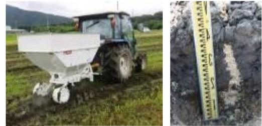
図2 疎水材心土充填機(左)と籾殻充填暗渠(右)
