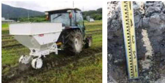
図2 疎水材心土充填機(左)と粗粒充填暗渠(右)
