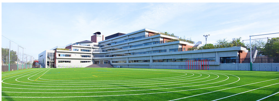
図1 東京農業大学稲花小学校校舎 都内世田谷区にあり、大学や高等学校・中等部のキャンパスに隣接している
