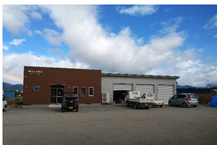
令和2年に建設された厚生施設「事務室兼作業準備室」。ミーティングコーナーのほか、休憩室、男女別の更衣室・トイレが備わる
