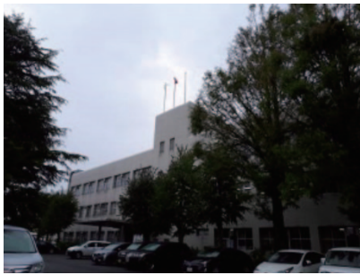
農林センター研究棟
