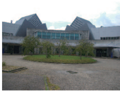
生物資源研究センター研究棟
