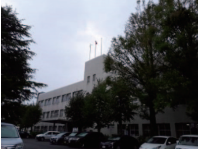
農林センター研究棟
