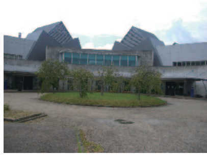
生物資源研究センター研究棟
