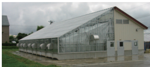
写真1 低温育種実験室の外観（十勝農業試験場）。室内の気温は自動制御。ガラス室は4室に分かれ、うち1室は短日処理できる
