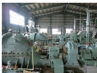
排水機場の 応急復興
