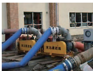
災害応急用 ポンプ設置
