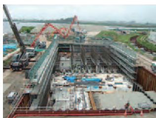
排水路・ 排水機場の 本格復旧工事中
