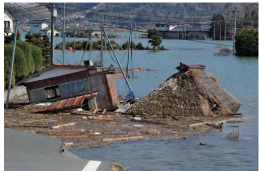
水没した大川地区
