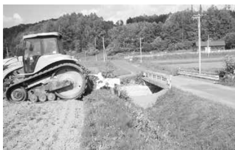
写真5-2 サブソイラの施工
