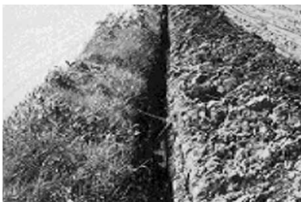
写真5-7 ほ場周辺の溝掘り
