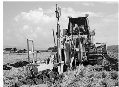
写真5-1 カットイングドレーン工法による無材暗渠の施工
