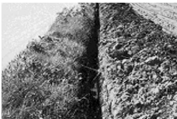
写真5-7 ほ場周辺の溝掘り
