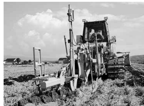
写真5-1 Cuttingドレーン工法による無材暗渠の施工
